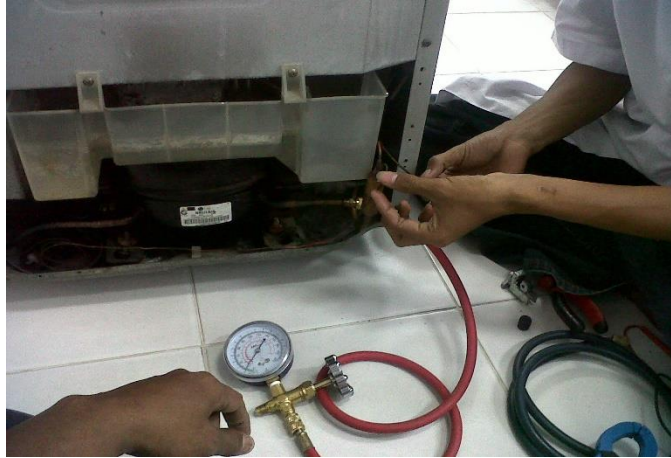
Gambar 2.9 Memastikan Gas Refrigerator Mengalir
