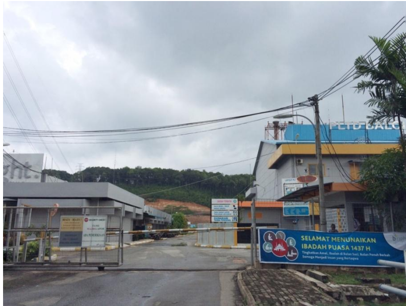
Gambar 3. Gedung pelaksanaan Kerja Praktik di PLTD Balo
