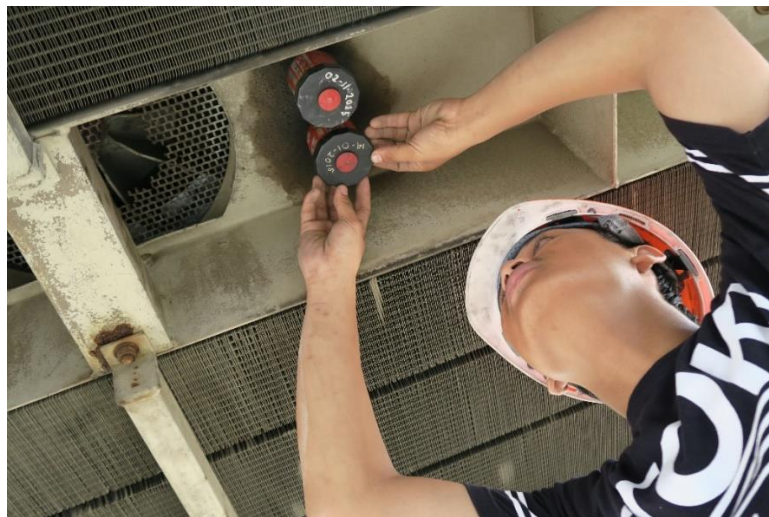
Gambar 3.3 Memeriksa greaser pada motor radiator
