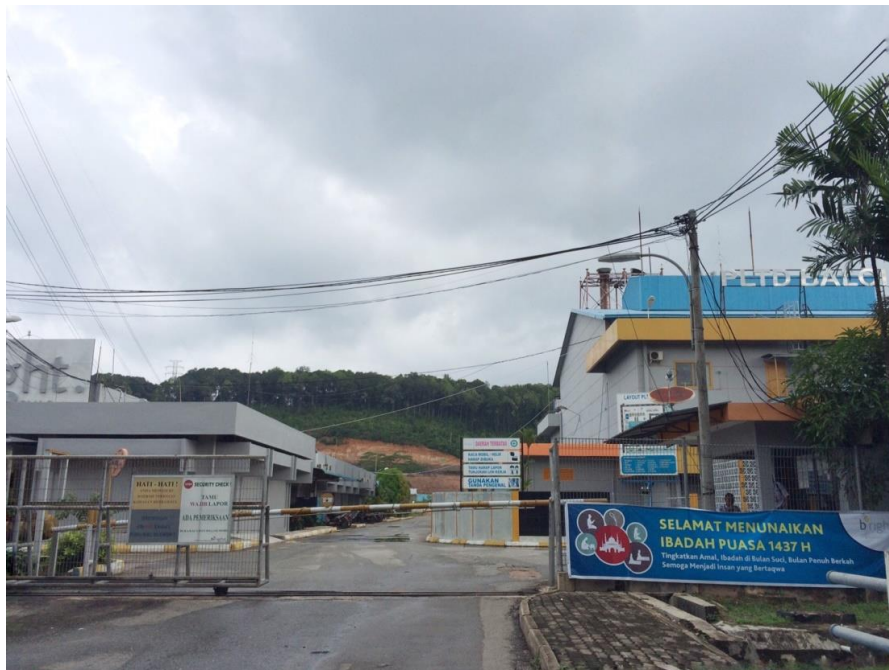
Gambar 5 Pusat pelaksanaan Kerja Praktek di PLTD Baloi
