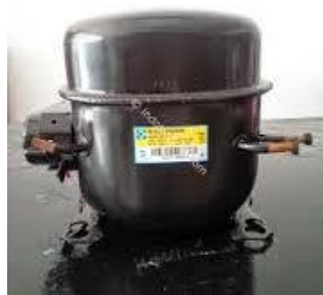
Gambar 3.3, Kompresor Kulkas
