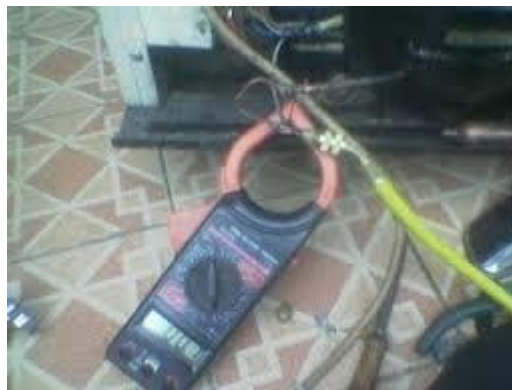
Gambar 3.16, Mengecek arus pada kompresor dengan menggunakan clamp ampere
