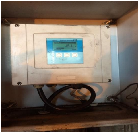
Gambar 3.6 Modul FMU90 bagian luar
