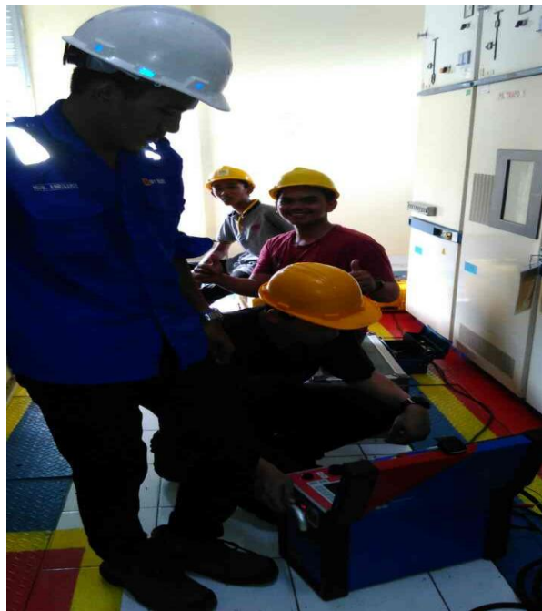
Gambar 3.3 pada saat Injeksi PMT
