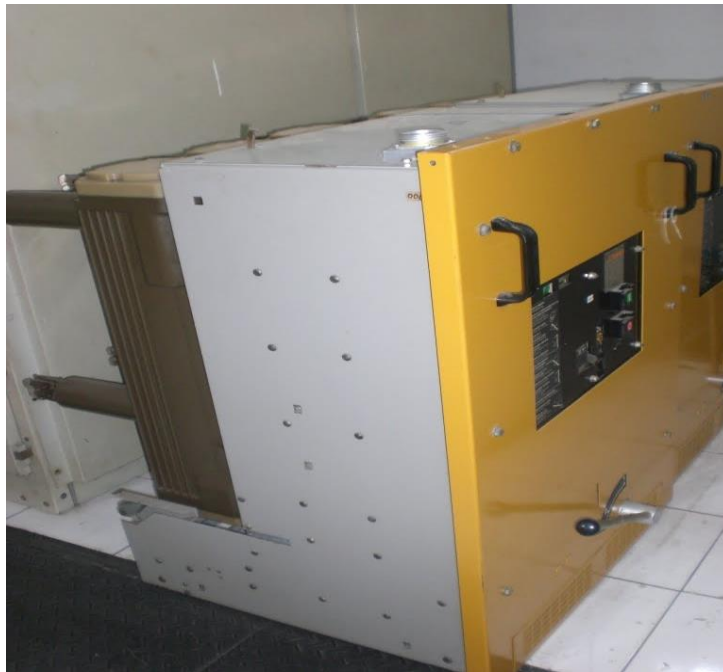
Gambar 3.1 PMT Gardu Induk Sungguminasa
